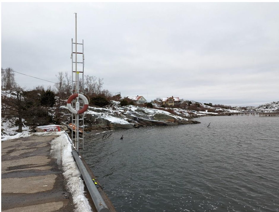
Figur 11. Befintlig kaj och strandlinje nedströms planområdet (Foto: Petter Mogenfelt)
